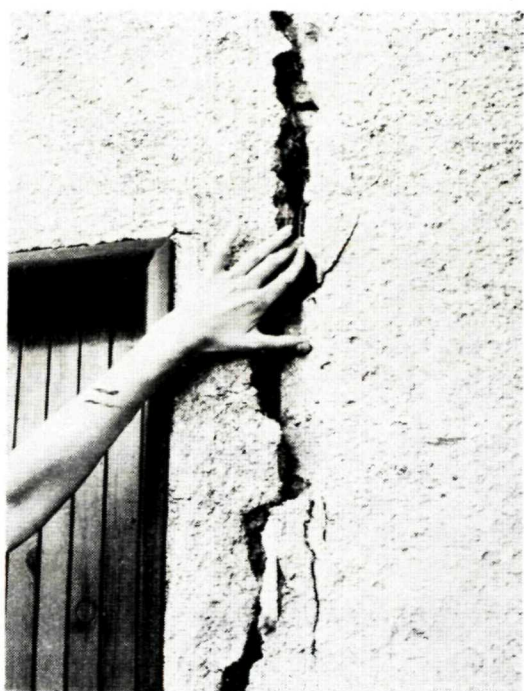
Obr. 4. Široké pukliny na obytnom dome vo Vrbovom vyvolali asanáciu objektu
